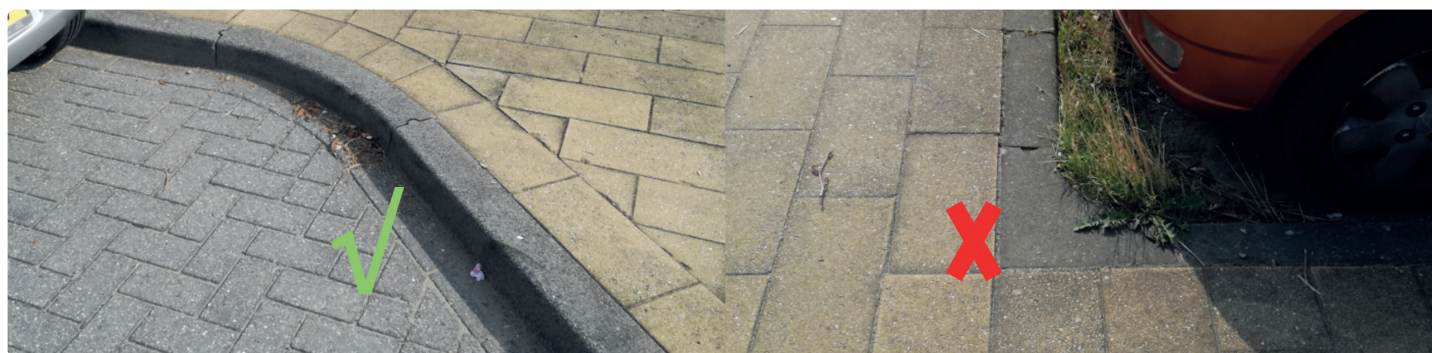
Links: parkeervak met ronde hoek waar borstel makkelijk doorheen kunnen om ophopend zand en onkruid te verwijderen. Rechts: rechte hoek, waar onkruid kan vestigen in opgehoopt zand.
