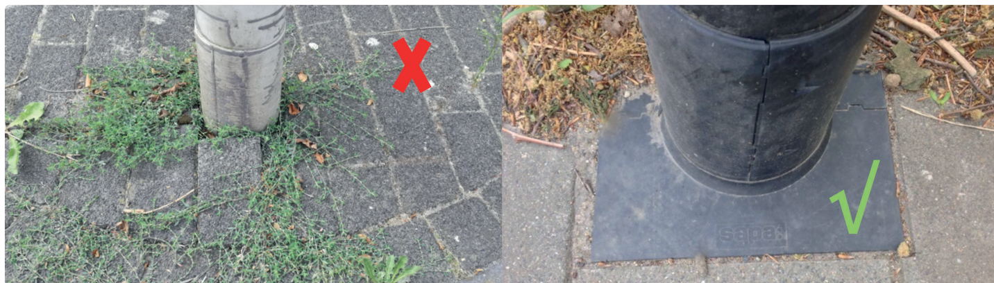
Links: lantaarnpaal op verharding. Door de open ruimte kan onkruid zich vestigen, maar is lastig te verwijderen. Rechts: lantaarnpaal in verharding met passtuk.
