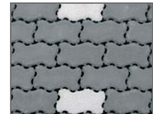
Betonstraatstenen met verbrede voegen
